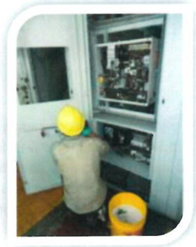
los tableros eléctricos de distribución, con interruptores, seccionadores y protecciones, garantizando así una mejor disponibilidad del servicio al interior de la ILC.
